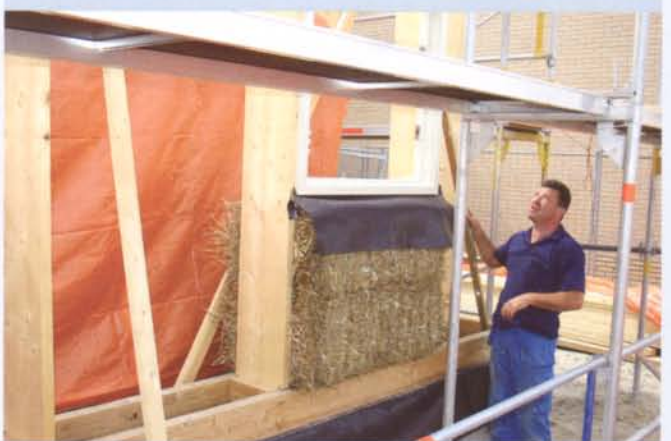
Bij de Q-woningen wordt het I(ndustrieel)F(lexibel)D(emontabel)-principe toegepast, zowel voor de bouw als voor de installaties. De industrieel vervaardigde bouwelementen worden in de bouw geplaatst.
