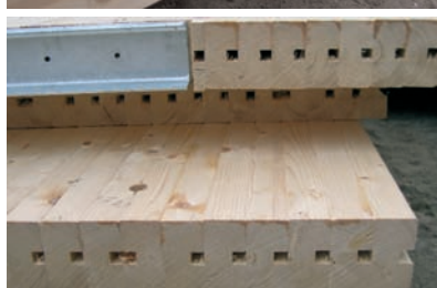
Dankzij kleine kanalen is er ruimte voor elektriciteitsleidingen en ontstaat flexibiliteit voor het plaatsen van lichtaansluitingen in het plafond.
